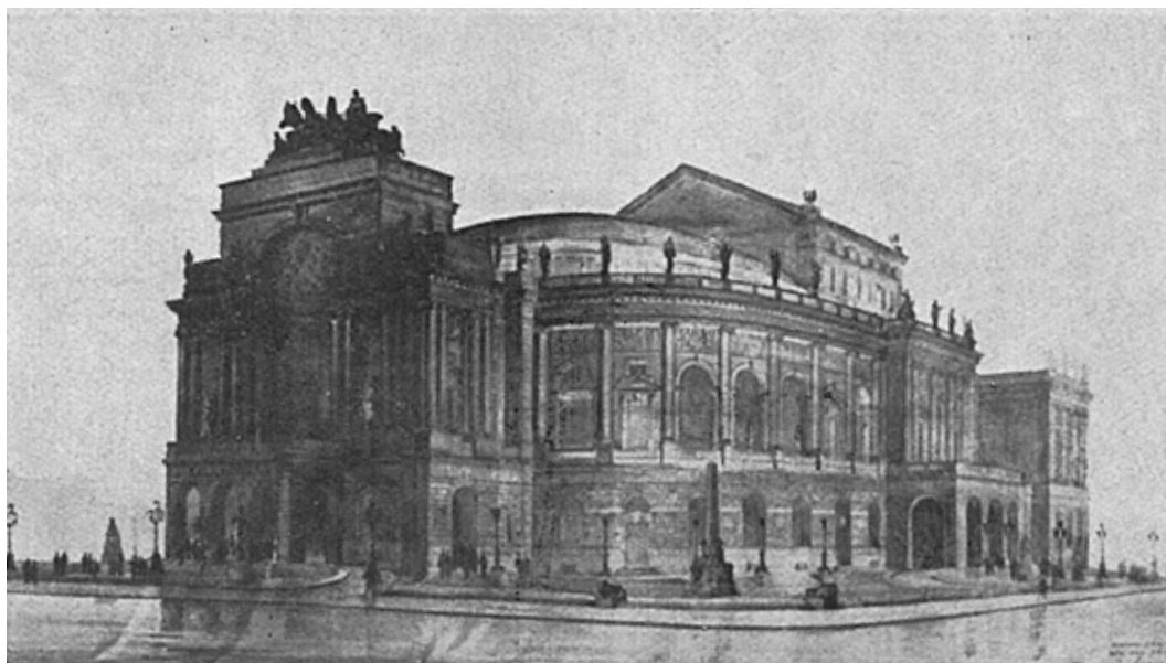
Fig. 1. Papkov's Batchelors project design (Source: Зрнић, Предраг (Ур.)). Публикација Клуба студената архитектуре, 1928.
